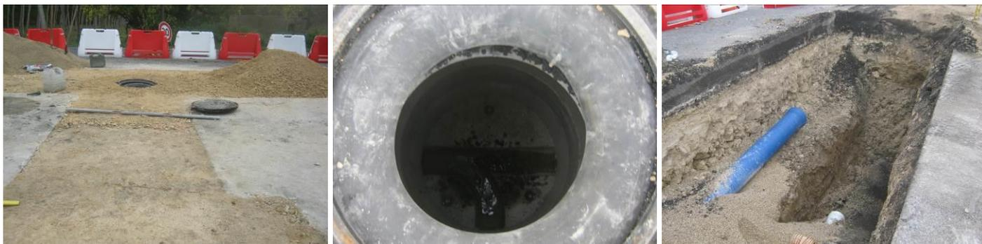
Amorce en demi-chaussée réalisée pour raccordement sur la canalisation AEP 150 fonte.
