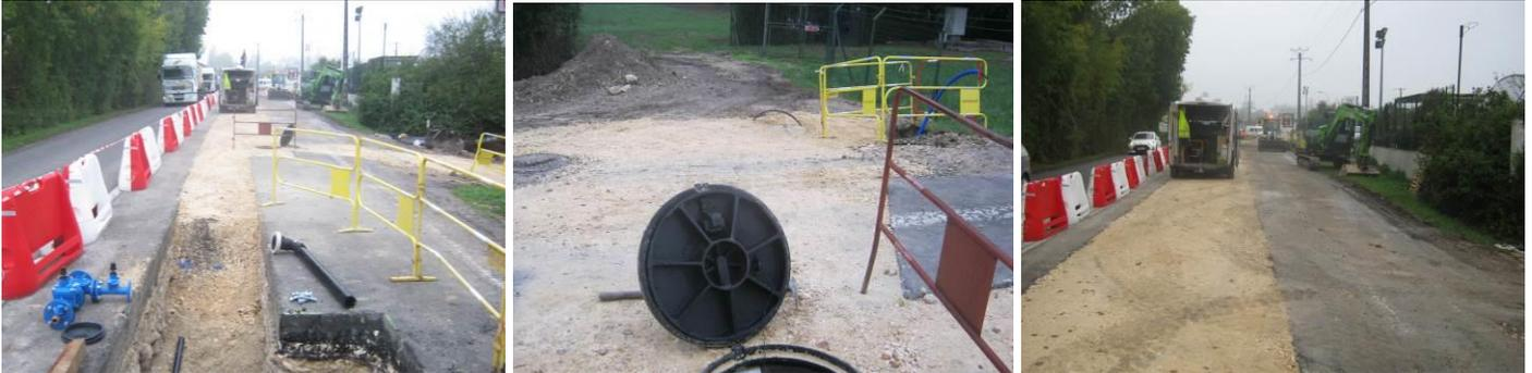
Pose de la vidange réalisée sur la canalisation AEP DN 250.
