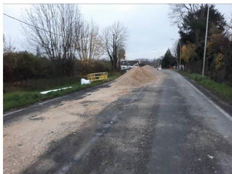
Mise à la côte des tampons réalisée + réfection provisoire en enrobé à froid sur 400 mètres environ.
